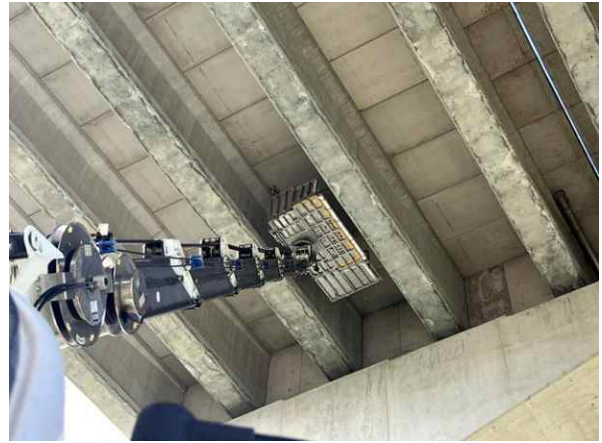
고소점검차를 이용한 근접조사
