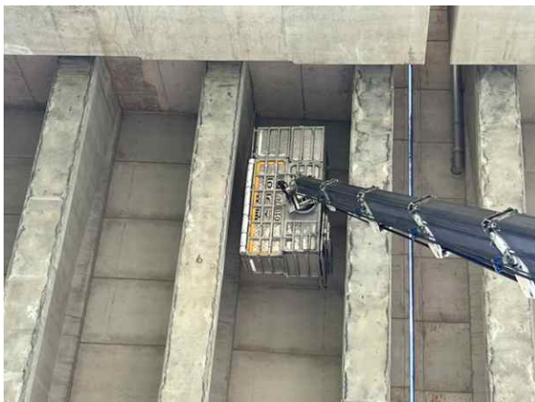
고소점검차를 이용한 근접조사
